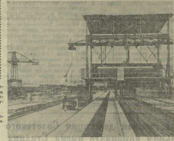
Рустави. На комбинате железобетонных изделий действует комбайн по изготовлению предварительно напряженных плит настла для междуэтажных перекрытий.
