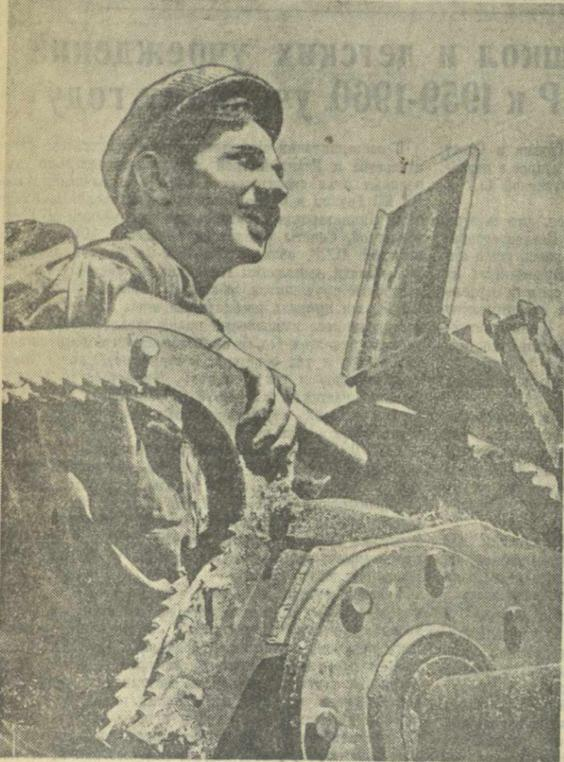
На нашем снимке — слесарь Демური Канакадзе. Он монтировал станок для изготовления крепежных рам, установленный сейчас на руднике. Раньше крепежные рамы делала вручную, 25 штук за смену. Чтобы обеспечить суточную потребность в рамах, нужно было трудиться 40 часов. А производительность станка такова — 120 в час.
