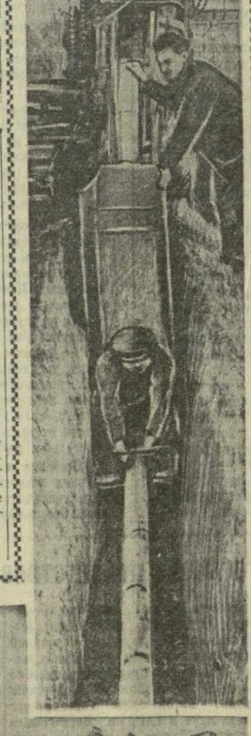
На снимках: 1. Новый экскаватор прокладывает траншею и укладывает трубы для дренажа. 2. Общий вид экскаватора.
