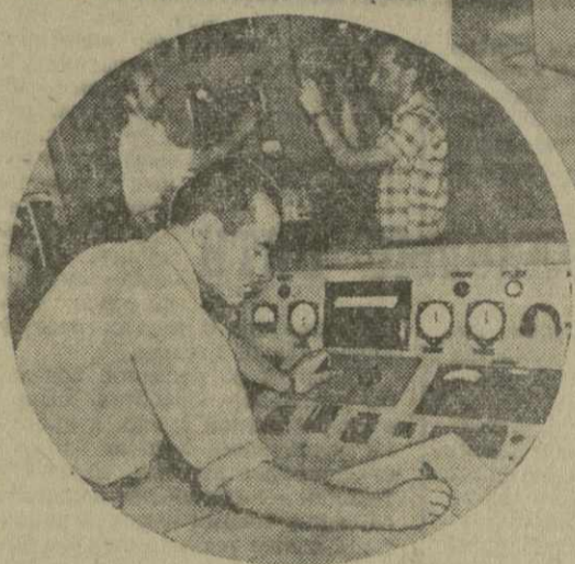
Идет монтаж центрального пульт управления. Фото Г. Вахтагандзе.
