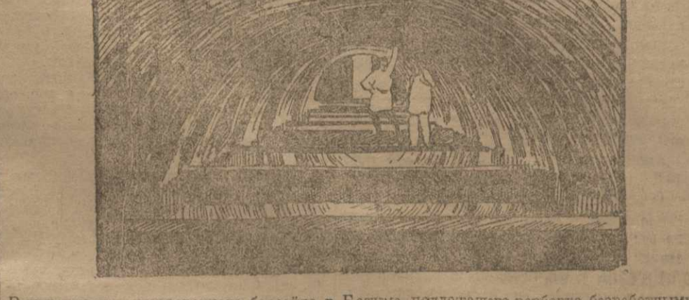
Внутренность волопроходного бассейна в Батуми, подлежащего работе безработными.
