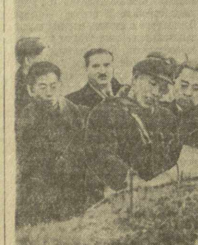
На снимке: премьер Государственного совета КНР Чжоу Энь-лай знакомится с проектом гидроузла Саньса на месте предполагаемого строительства. Докладывает главный инженер Комитета комплексного использования реки Янцзы Ли Джен-пай. Третий слева инженер Г. Я. Менабде.
