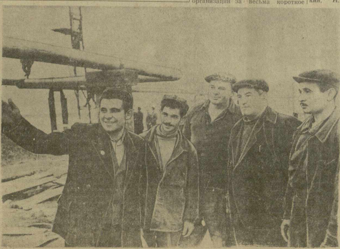
На снимке — передовые строители газопровода Карадаг — Тбилиси (слева направо): инженер газопровода С. Юханян, арматурщик М. Будник, начальник участка А. Лебов и бульдозерист М. Алиев. Фото Г. Вахтагандзе.
