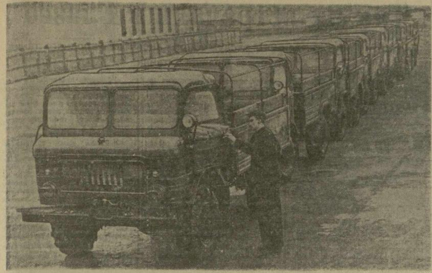
Горький. На автомобильном заводе выпущена первая партия грузовых автомобилей ГАЗ-62. Новая машина грузоподъемностью в одну тонну имеет форкамерный двигатель мощностью в 80 лошадиных сил. Благодаря передним и задним ведущим осям ГАЗ-62 отличается высокой проходимостью. Автомобилестроители обязались ко дню открытия декабрьского Пленума ЦК КПСС выпустить еще 30 таких машин. На снимке: автомобиль ГАЗ-62. Фото О. Ярчевского. (Фотохроника ТАСС).
