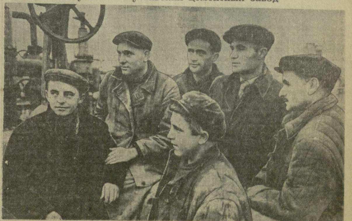
На снимке: группа отличившихся монтажников и работников газораспределительной станции в Рустави (слева направо): наладчик В. Белоусов, бригадир слесарей-монтажников Н. Подольский, оператор Ш. Каркузашвили, изоляторщик трубопроводов Е. Фоменков, наладчик И. Селиков и оператор Э. Азкури. Фото Г. Вахтагандзе.
