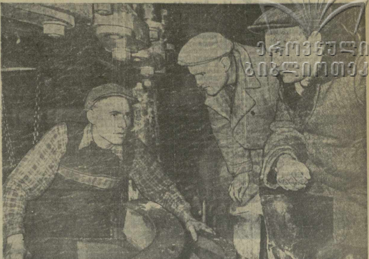
На снимке (справа налево): начальник Кавказского участка Всесоюзного треста «Спецгазрознергомонтаж» Г. Лохматиков, старший прораб В. Прияников и слесарь-регулировщик Е. Пичкин за монтажом агрегата Ладжанурской ГЭС. Фото Г. Вахтагандзе.
