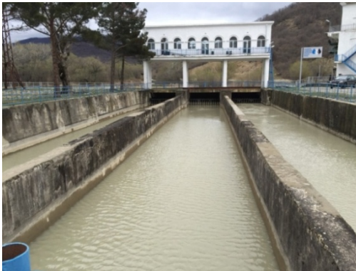
სურ. 6.4. მდ. იორზე სათავე ნაგებობა (საგარეჯოს რაიონი, სოფ. პაღლო): ა) წყლის გადაღინება პრაქტიკული პროფილის წყალსაშუზე; ბ) წყალმიმღები კვანძის საერთო ხედი; გ) სამკამერაიანი სალექარის საერთო ხედი; დ) შემაუღლებელი ნაგებობის საერთო ხედი
