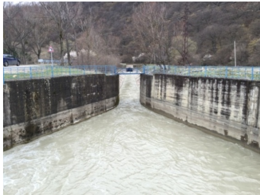
სურ. 6.4. მდ. იორზე სათავე ნაგებობა (საგარეჯოს რაიონი, სოფ. პაღლო): ა) წყლის გადაღინება პრაქტიკული პროფილის წყალსაშუზე; ბ) წყალმიმღები კვანძის საერთო ხედი; გ) სამკამერაიანი სალექარის საერთო ხედი; დ) შემაუღლებელი ნაგებობის საერთო ხედი
