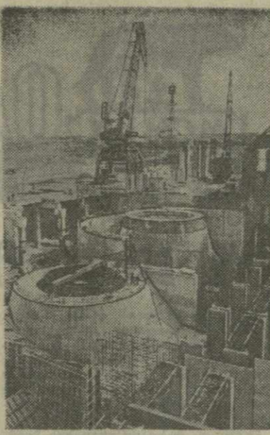
Днепропетровская область. Новых трудов успехов добились строители Днепропетровской ГЭС. Они досрочно закончили монтаж облицовочного кольца кофры на втором агрегате. На снимке: на строительстве ГЭС. Фото Г. Назенов. (Фотохроника ТАСС).
