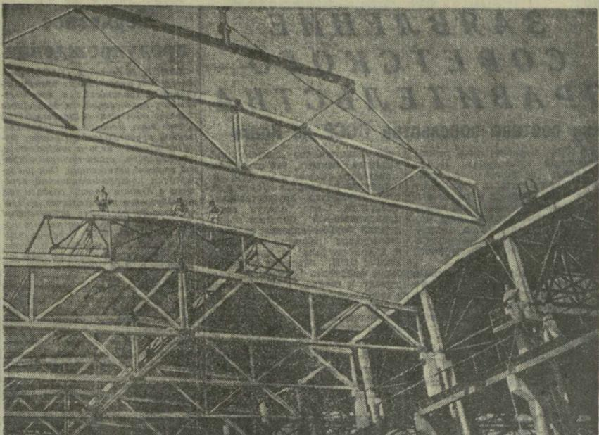
На снимке: снят монтаж напряженно армированных железобетонных ферм пролетом в 24 метра на строительстве трубопроводного цеха Закавказского металлургического завода имени И. В. Сталина. Освоение производства таких ферм — большой успех коллектива комбината железобетонных изделий треста «Закметаллургстрой».
