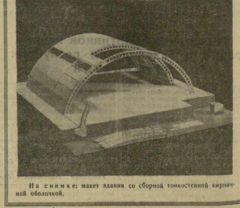
На снимке: макет здания со сборной тонкостенной кирпичной оболочкой.
