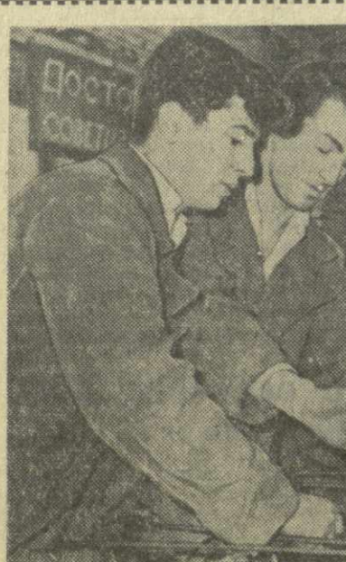
Увлеченным работают студенты-практиканты строительного факультета Грузинского политехнического института имени В. И. Сталина на Тбилисском заводе железобетонных изделий № 1 «Глаубетрастор». Ребята собирают арматурные сетки для деталей купола Дворца спорта. Сейчас они строятся, а скоро будут зрителями и участниками спортивных событий, которые разгорятся под куполом Дворца спорта.
