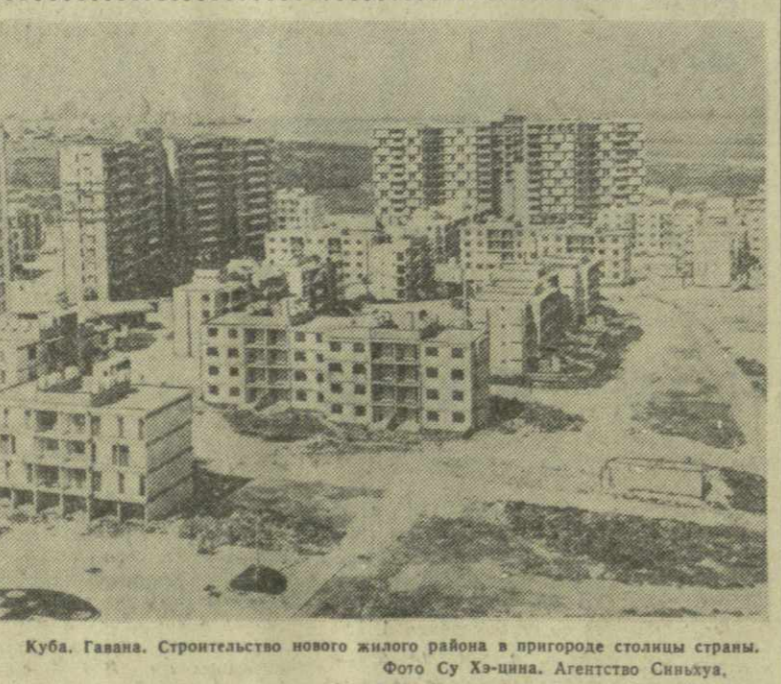
Куба. Гавана. Строительство нового жилого района в пригороде столицы страны. Фото Су Ха-цина. Агентство Синьхуа.
