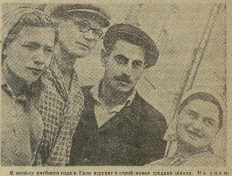
К началу учебного года в Гали вступил в строй новая средняя школа. На снимке: члены бригады строителей (слева направо): Р. Чухрава, И. Ковернев, десятник Г. Нармания и Г. Осипенко.
