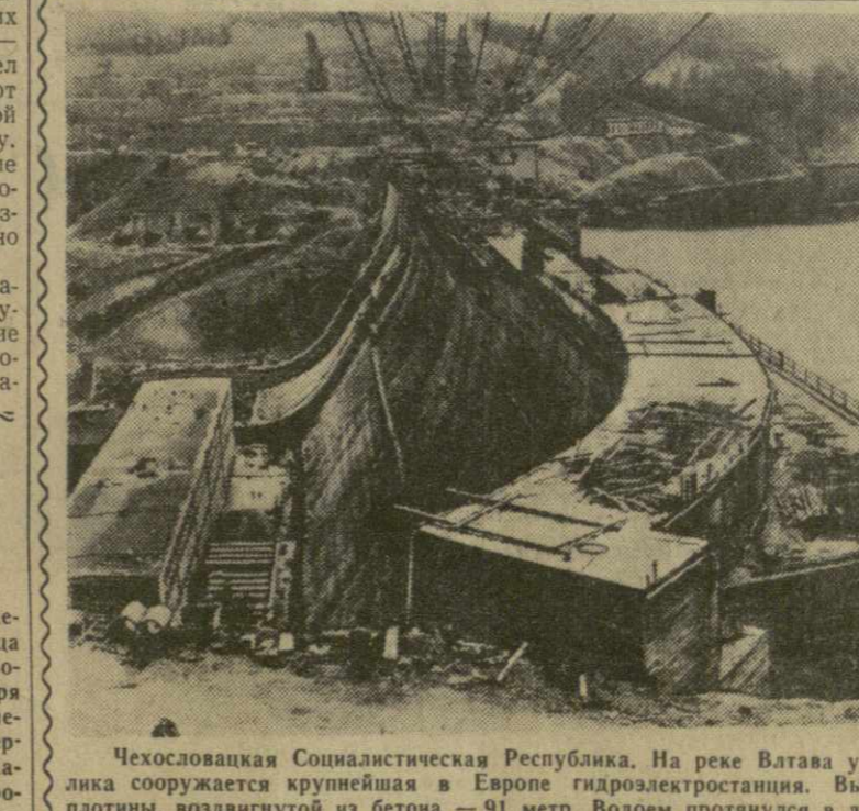
Чехословацкая Социалистическая Республика. На реке Ватава у Орляки сооружается крупнейшая в Европе гидроэлектростанция. Высота плотины, возведенной из бетона, — 91 метр. Водоем протянулся в длину на 71 километр. На снимке: строительство плотины у Орляки. Фото И. Рубича, ЧТА.
