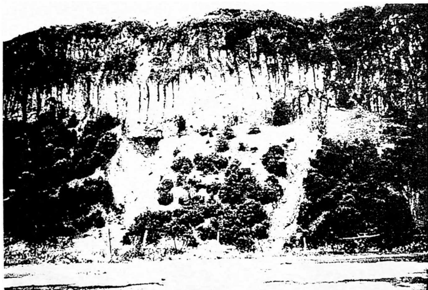
სურ. 10. მთის ფერდის დახრამეა, სოფ. ნაღვარევი Рис. 10. Изборожденный горный склон, с. Нагвареви 10. Furrowed mountainside, village Nagvarevi
