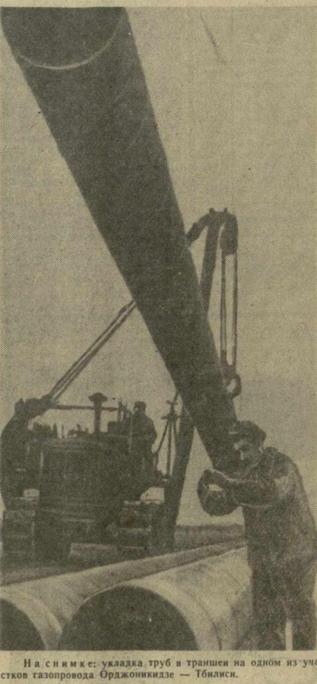
На снимке: укладка труб в траншеи на одном из участков газопровода Орджоникидзе — Тбилиси.
