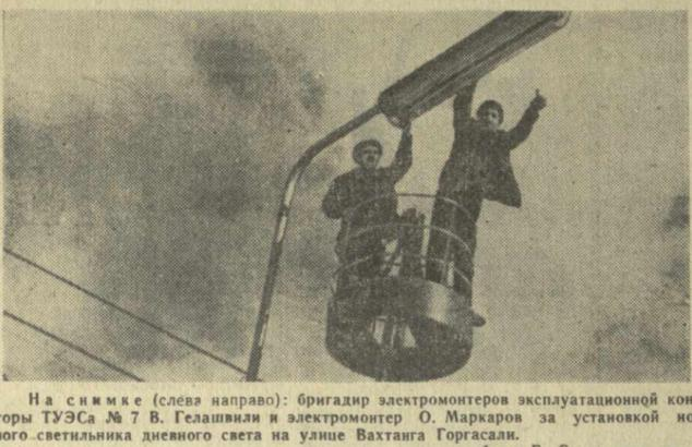
На снимке (слева направо): бригадир электромонтеров эксплуатационной конторы УЭС № 7 В. Гелашвили и электромонтер О. Маркаров за установкой нового светильника дневного света на улице Вахтанга Горгадзе. Фото Е. Суэнукишвили.
