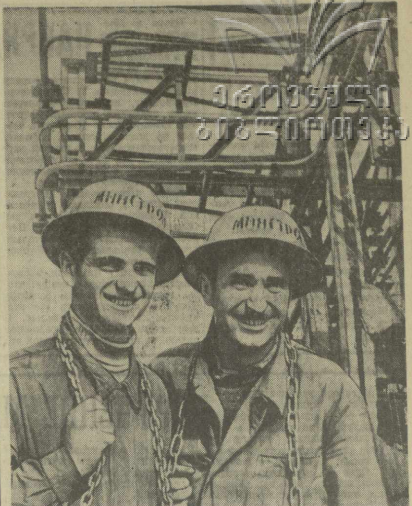
На снимке: передовые монтажники «Металлургпрокатмонтажа», работающие на строительстве Руставского производства капролактама (слева направо) Гурам Капанадзе и Нодар Зегинидзе. Фото Е. Суусунакшвили.
