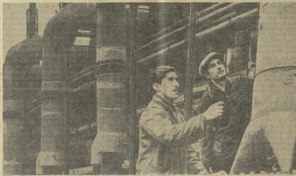
Закончилось строительство корпуса циклогексанола-сырца Руставского производства капролактама. На снимке: аппаратчики Р. Цикаури (слева) и А. Гургендзе проверяют один из участков корпуса перед пуском. Фото М. Квирицхиаши.
