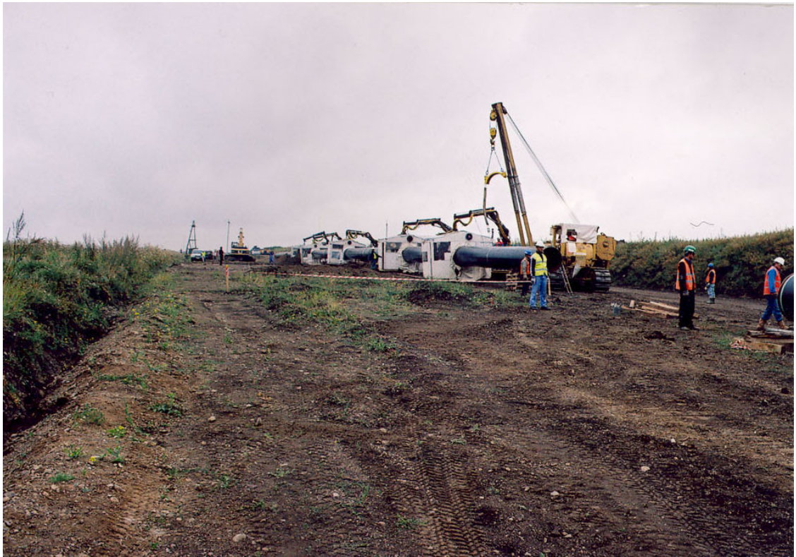
სურ. 18. ჯინისის ნამოსახლარის აღმოსავლეთი კიდე- გაზსადენის მილების შედუღების პროცესი. ხედი დასავლეთიდან.
