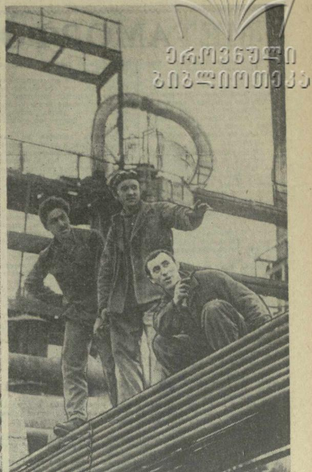
На Батумском нефтеперерабатывающем заводе завершается автоматизация пяти установок в цехе № 2. На снимке: монтажники Ю. Чуприков, Р. Анвазия и Д. Метревели проверяют импульсные трассы автоматической линии. Фото С. Киладзе.
