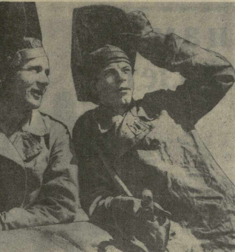
Строительство газопровода Орджоникидзе — Тбилиси. На снимках: сверху — газовые трубы готовы к перевозке для укладки. Внизу — переводные сварщики участка № 2 строительного-монтажного управления № 4 треста «Южгазопроводстрой» Николай Иларонов (слева) и Иван Лукин.
