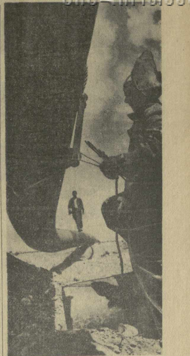
На одном из участков строительства газопровода Орджоникидзе — Тбилиси. Фото Э. Песова. (АПН).
