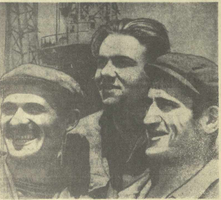
Скоро войдут в эксплуатацию агрегаты первого блока Тбилисской ГРЭС. Строители и монтажники изо дня в день наращивают темпы работ. На снимке: переводы монтажники особо важной стройки Л. Демельханов, Н. Игнатов, А. Сытик.
