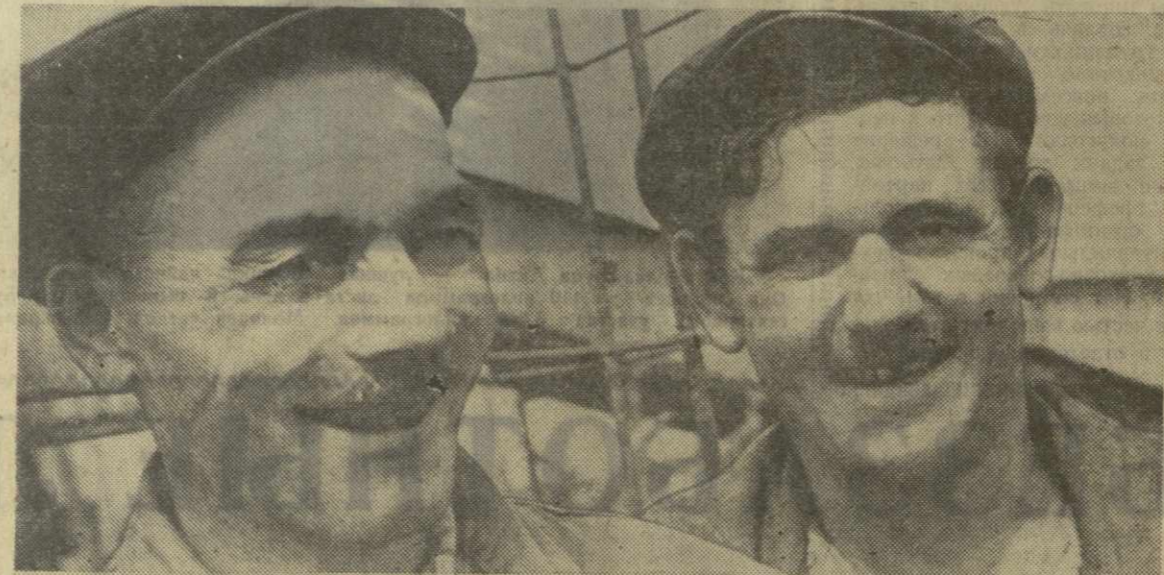
На с и м к е: передовые арматурщики 4-го участка «Ингуригэсстрой» Н. Чинчараули и В. Стрельников. Фото С. Кикадзе.
