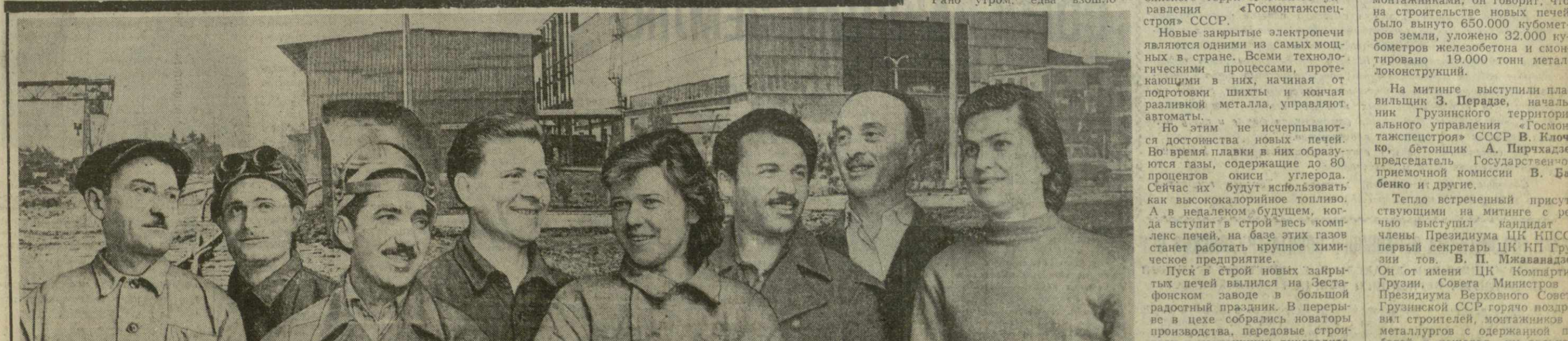
Вот они, слабые строители и монтажники, отличившиеся на сооружении нового плавильного цеха Зестафонского ферросплавного завода (слева направо): бригадир плотников Георгий Палидзе, бригадир комплексной комсомольско-молодежной бригады Вахтанг Гигашивили, электросварщик Илья Мусаев, электромонтажник Валерий Березин, газосварщик Нина Алимашва, электромонтажник Нодар Джанаидзе, начальник участка Кукури Никобадзе, инструментальщик Сулико Махатадзе.
