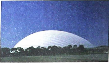
ნახ. 13. ჯუჯაის ოვალური გუმბათი, r_1 = 178 მ, r_2 = 157 მ. (იაპონია, ქ. ოდატე, აკიტას პრეფექტურა).
