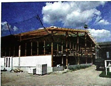
ნახ. 10.23. თანამედროვე ხის კარკასული კონსტრუქცია სამრეწველო შენობისათვის (გერმანია).
