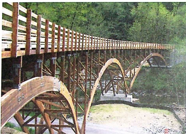
ნახ. 15. ხის თაღოვანი ხიდი, სიგრძე 118,57 მ ( ქ. ბაკლი, აშშ. ვაშინგტონის შტატი).
