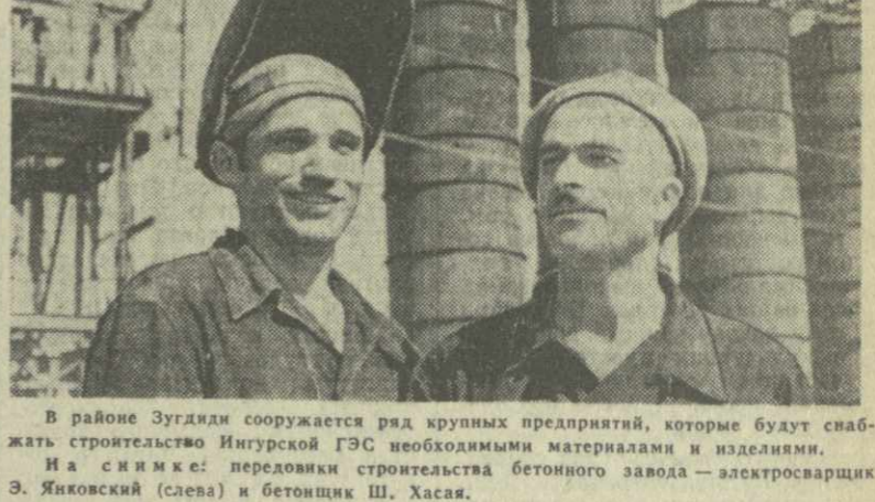
В районе Зугдиди сооружается ряд крупных предприятий, которые будут снабжать строительство Ингульской ГЭС необходимыми материалами и изделиями. На снимке: передовики строительства бетонного завода — электросварщик Э. Яковлевский (слева) и бетонщик Ш. Хасая. Фото М. Квирикашвили.
