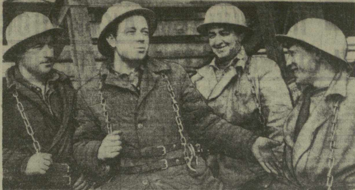
Быстрыми темпами идет строительство второй очереди Зестафонского ферросплавного завода. Строители и монтажники решили завершить все работы к концу нынешнего года. Весь коллектив стремится выполнить эту почетную задачу. Самоотверженный труд рождает героев труда. Смелыми и отважными называют здесь монтажников-верхолазов из бригады Валерия Чинакалова. Эти бесстрашные люди работают четко и слаженно. Они одни из первых стали на трудовую вахту в честь выборов в местные Советы. Свои сменные задания бригады коммунистического труда, монтажники-верхолазы (слева направо) Э. Перадзе, бригадир В. Чинакалов, О. Джаошвили и А. Сисаленко. Фото А. Мачавариани. (Фотохроника ГрузТАГА).
