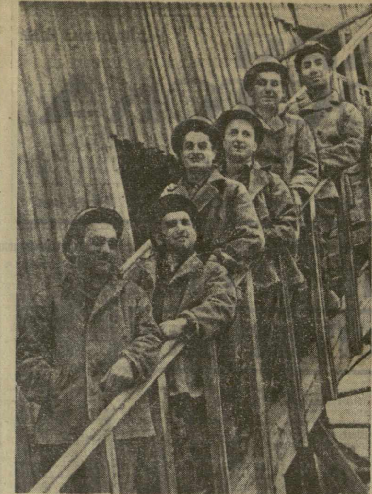
Бригада коммунистического труда слесарей-монтажников строительства Тбилисского метрополитена (слева направо): Ш. Гагидзе, Г. Чумбуридзе, И. Капанадзе, Л. Сиуга, Д. Кемоладзе и руководитель бригады А. Даташвили.
