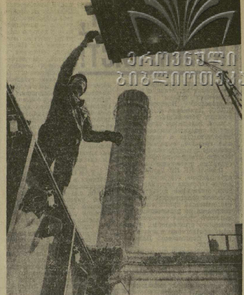
На Тбилисской ГРЭС начался монтаж третьего блока. А тем временем два блока электростанции уже успешно действуют. В нынешнем году завершится строительство третьего блока и будет достигнута проектная мощность станции. Но на этом работы не закончатся. Теперь стоит вопрос о дальнейшем расширении Тбилисской ГРЭС, увеличении ее мощности. Уже ведутся работы по четвертому блоку. Затем намечается строительство и пятого блока.
