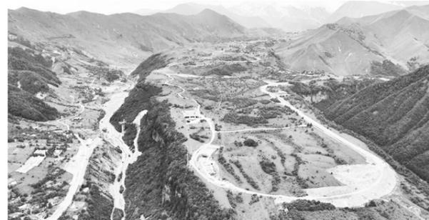
В рамках проекта строится четырехполосная цементно-бетонная скоростная дорога. Первый участок дороги - объездная дорога Вазияни была сдана в эксплуатацию в прошлом году, и четырехкилометровый участок новой дороги уже используется автотранспортом. На остальных двух участках общей протяженностью 31 км активно ведутся работы, завершение которых планируется в этом году.
