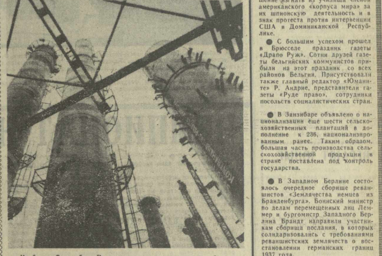
На берегу Вислы близ Пулава расположена одна из крупнейших новостроек нынешней польской пятилетки — комбинат азотных удобрений. В этом году будет завершено сооружение первой линии. Ее среднегодовая производительность — 300 тонн аммиака и 500 тонн искусственных удобрений. На снимке: мощные установки комбината-гиганта. Фото ЦАФ—ТАСС.
