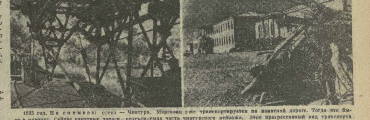
1935 год. На снимках: слева — Чхатра. Марганец уже транспортируется по канатной дороге. Тогда это было в новинку. Сейчас канатные дороги — неотъемлемая часть тифлиского пейзажа. Этот прогрессивный вид транспорта прочно вошел в привычку и был нашей республикой. Справа — заводский комплекс. Построены новые жилые дома. Но еще сохранилась и старая хижина (ее вы видите на переднем плане).
