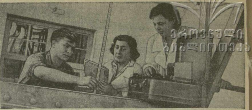
В отделе гидротехники Грузинского научно-исследовательского института гидротехники и мелиорации проводятся исследования размытия и защиты берегов морей и водохранилищ. На с и м к е: группа сотрудников во время проведения опыта по проверке эффективности работы нового типа затопленного волнолома. Слева направо: научные сотрудники Евгений Масс, Лиана Нуцубидзе и руководитель темы — старший научный сотрудник, кандидат технических наук Нина Варазашвили. Фото М. Суцуникашвили.
