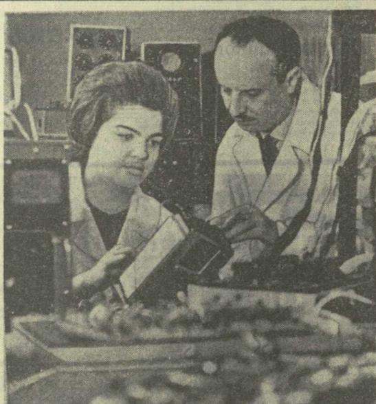
В отделе элементов автоматики Института электроники, автоматики и телемеханики разрабатывается электронное устройство для автоматического контроля геометрических размеров труб в процессе их изготовления. На снимке: лаборантка отдела Р. Джанкарашвили (слева) и руководитель отдела, кандидат технических наук О. Хомерки с проверкой электронного счетнорешающего блока. Фото Е. Суцуникашвили.
