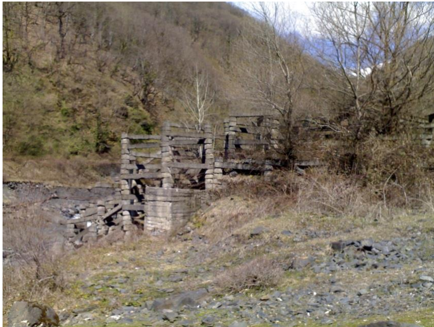
ნახ. 7.1. ი.ხერხეულიძის ცხავური ტიპის სელდამჭერი ნაგებობა
