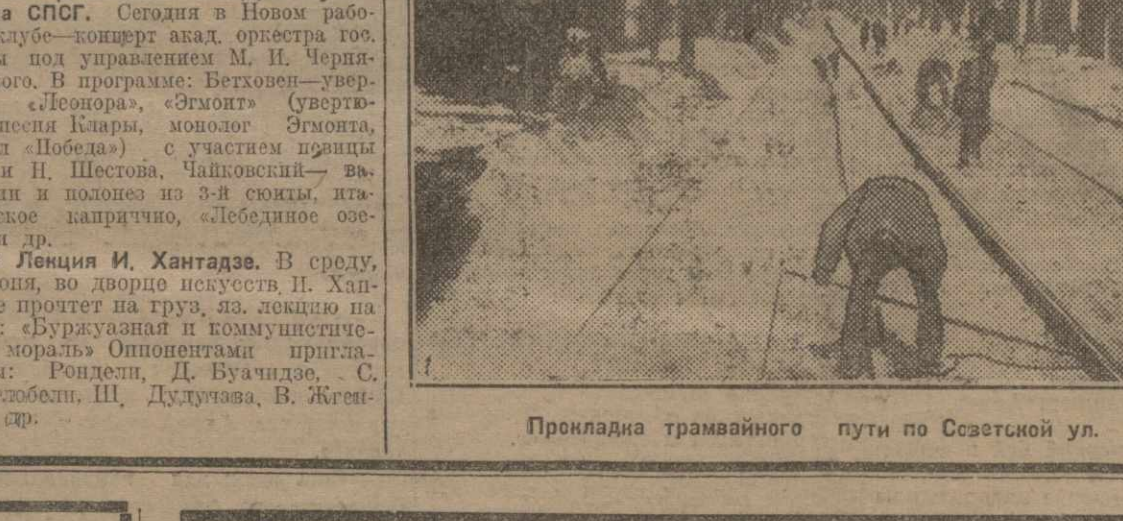
Проклада трамвайного пути по Севастской ул.
