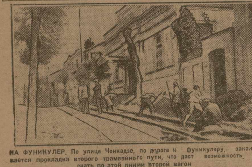
МА ФУНИКУЛЕР. По улице Чкалова, по дороге к фуникулеру, заказчик высекает прокладку второго промежуточного пути...
