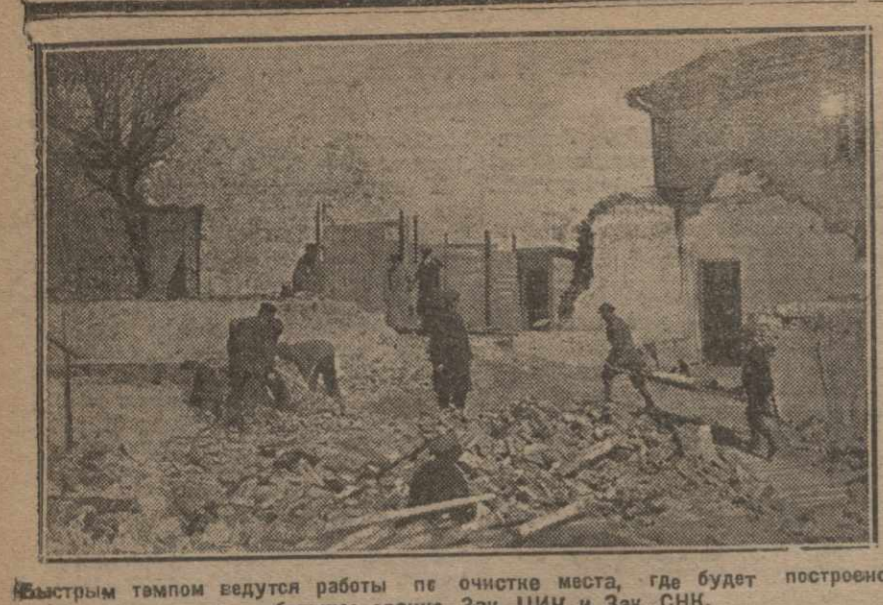
Быстрым темпом ведутся работы по очистке места, где будет построено новое здание Зав. ЦИИ и Зав. СНК.
