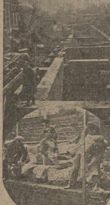
На стройке дома Заг. ГПУ.
