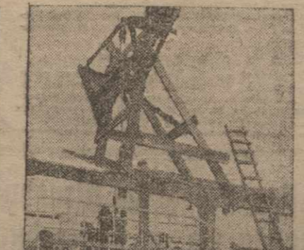
БАТУМ. Строят нефтеперерабатывающий завод Азербайджана
