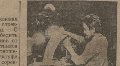
БАТУМ. Цинковальный завод. Ученик аджарец за загибкой цинка для труб.
