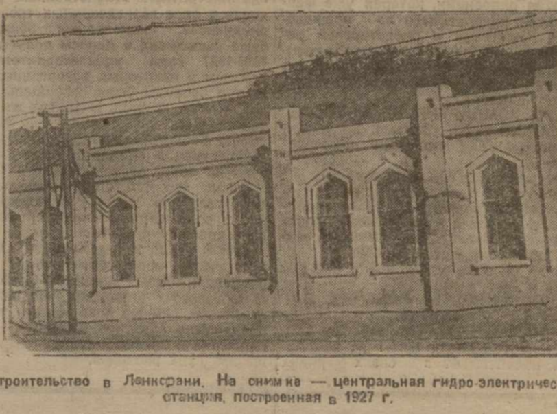
Строительство в Ленсране. На снимке — центральная гидро-электрическая станция, построенная в 1927 г.
