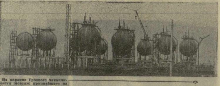
На окраине Грозного заканчивается монтаж крупнейшего на Северном Кавказе парка шаровых резервуаров для хранения нефтепродуктов под давлением. Емкости смонтированы конструкторами Грозненского специализированного управления ордена Ленина треста № 7.
