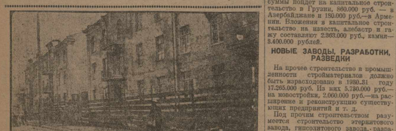
В Ленинском районе (Тбилиси) строится рабочий поселок индустриального района. На фото — первые дома поселка.
